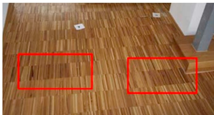
Häufung dunkler Hochkantlamellen (rot markiert). Bei dieser Parkettart ist die Plakatbildung zulässig (= kann nicht reklamiert werden).
