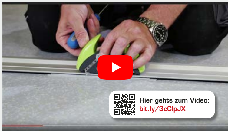
Doppelnahtschnitt mit dem geführten Nahtschneider „Railcut“.
